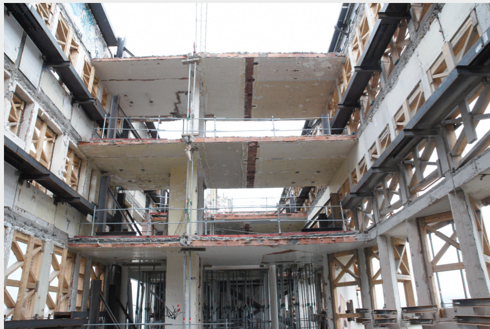
Restructuration lourde de l'Ancien Sanatorium de Sabourin en école d'architecture Clermont Ferrand - Dominique Lyon Architectes
